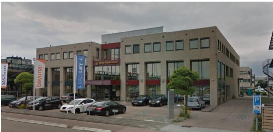
Afbeelding: huidige bebouwing projectlocatie
