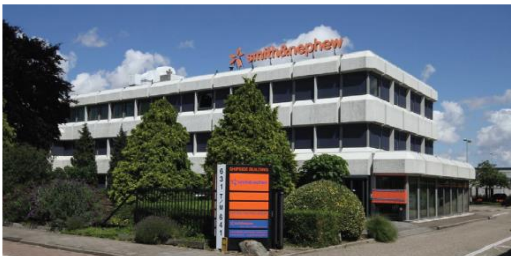
Afbeelding: huidige bebouwing projectlocatie
