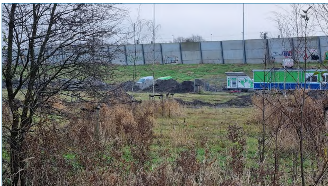
Figuur 6. Werkzaamheden ten oosten van de bosschage.
