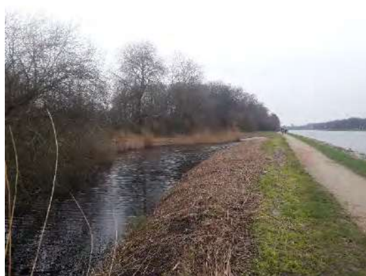
Foto 2: leidingtracé langs de Bosbaan in het Amsterdamse bos in Amstelveen
