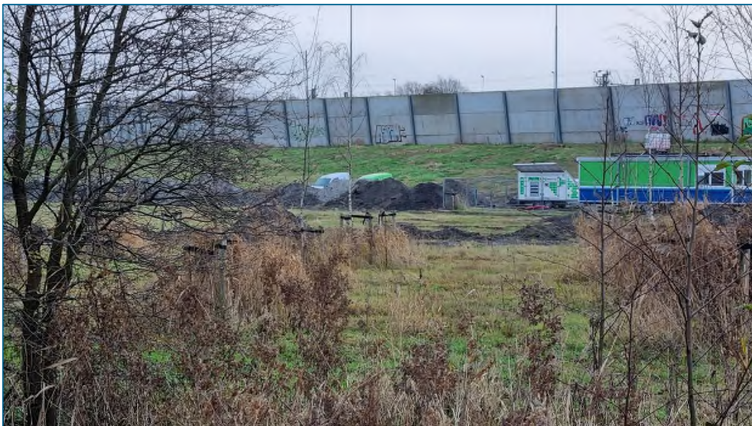
Figuur 6. Werkzaamheden ten oosten van de bosschage.
