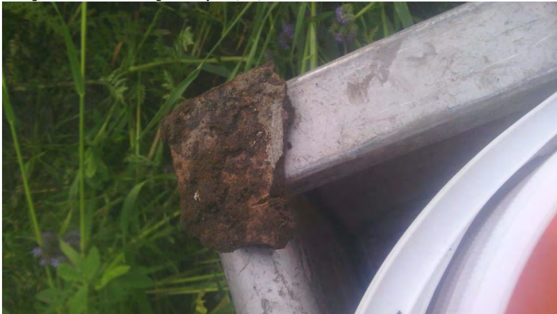
Proefgat 0704: aangetroffen stukje asbestverdacht materiaal
