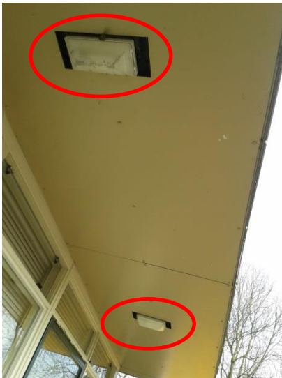
Figuur 4.3 overkapping oostelijk gebouw
