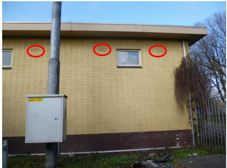
Figuur 4.4 toegang tot muren westelijk gebouw
