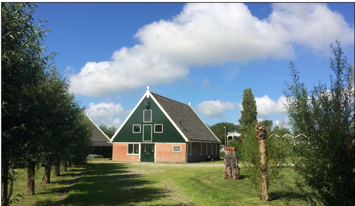
Afbeelding: het gebouw van de Timmerloods/werkplaats
