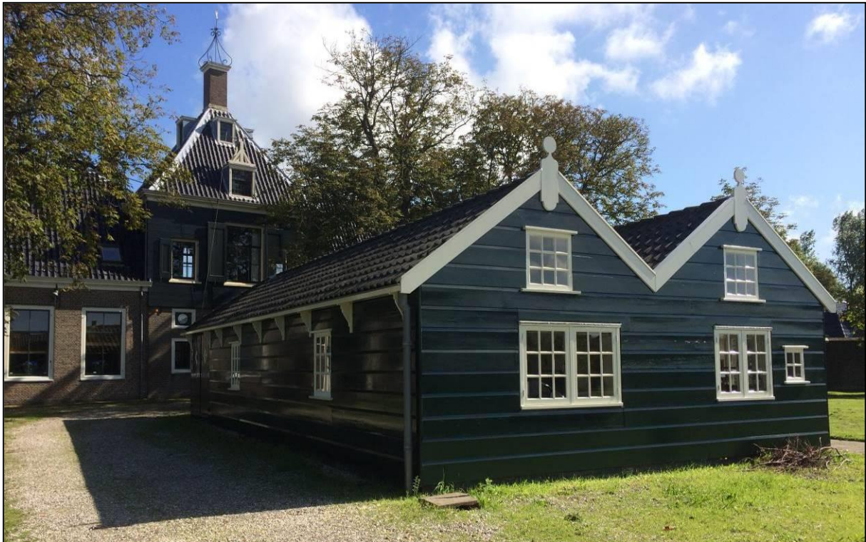
Afbeelding: het gebouw van de kettingsloods
