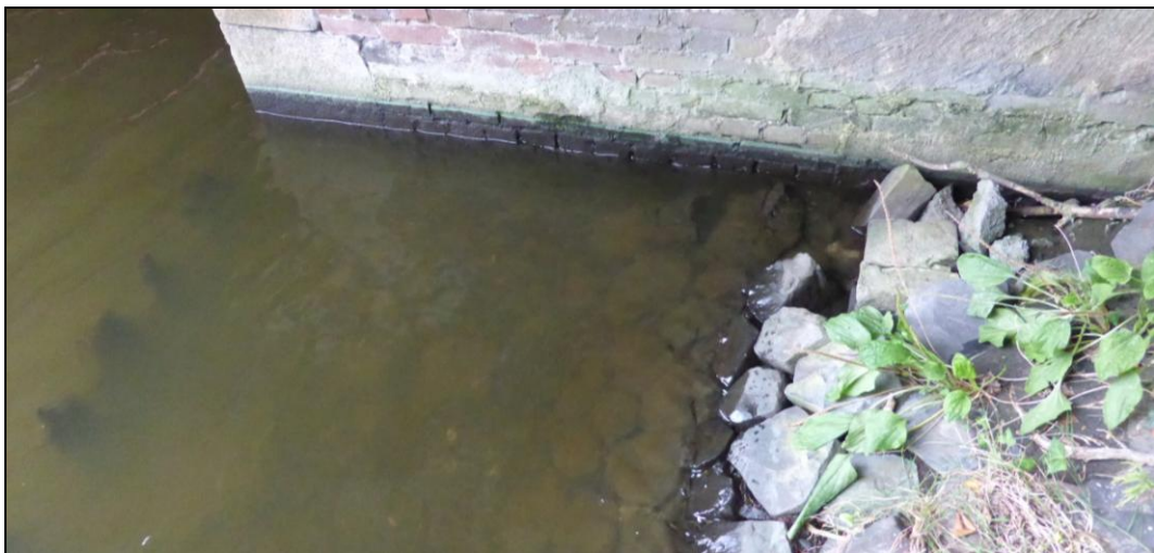
Afbeelding 16. Steenstort rond brugpijlers.
