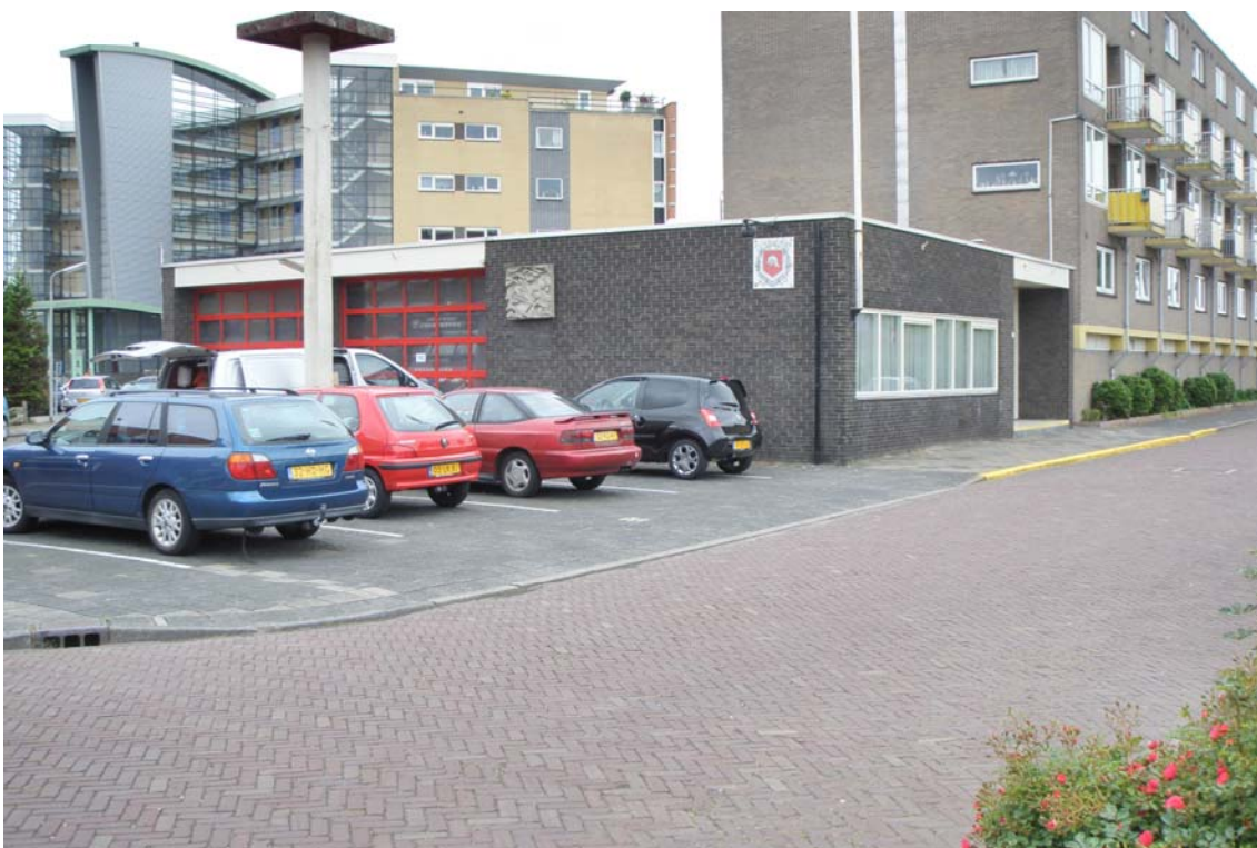
Voorzijde brandweerkazerne met parkeerplaatsen
