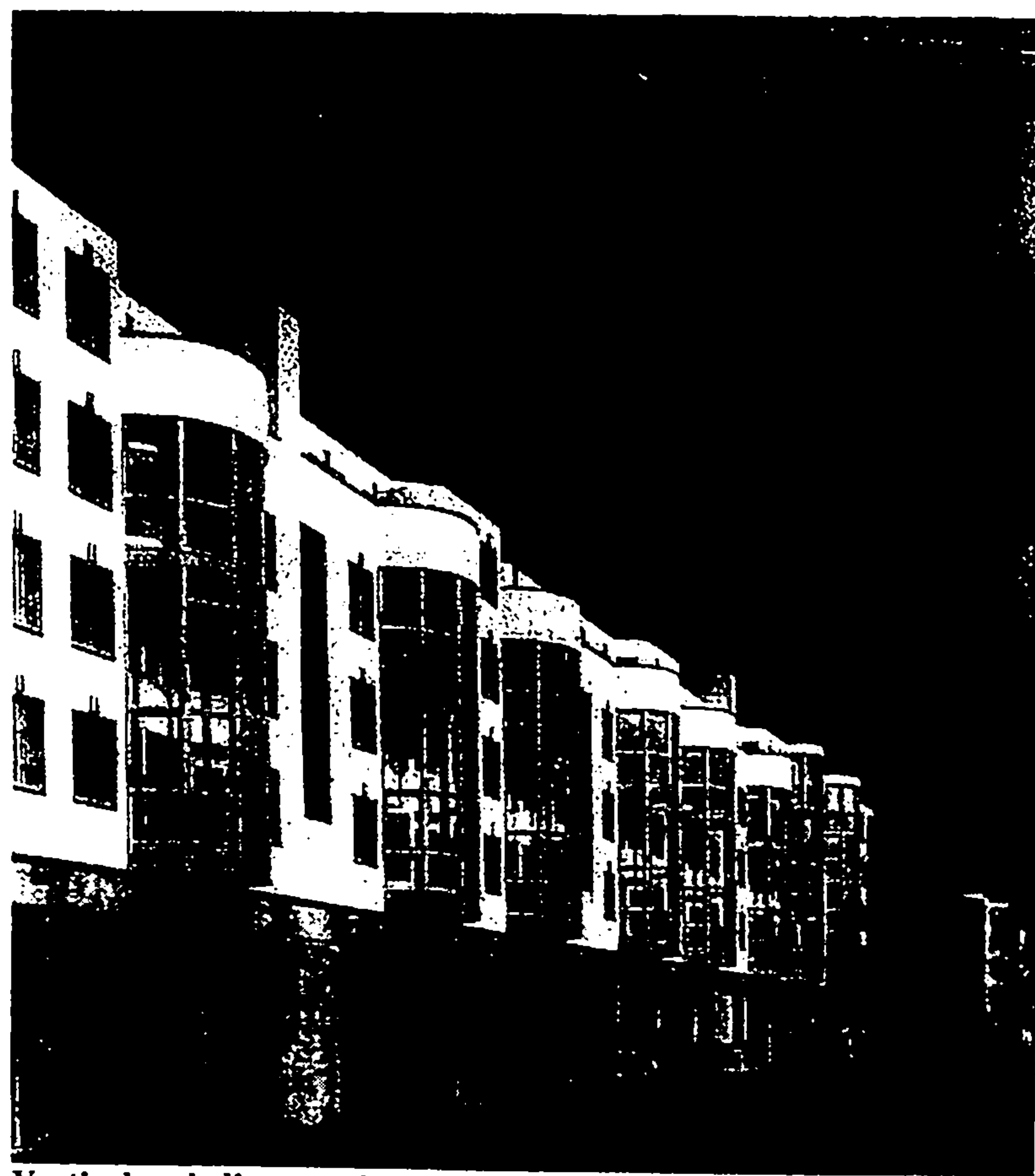
Verticale geleding van de gevels
