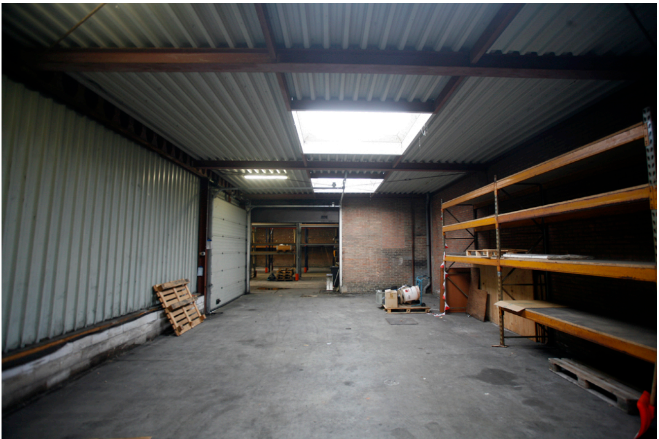
Afb.4: Een van de panden in fase 2B. Enkelsteens muur en golfplaten dak. Geen mogelijkheden voor vleermuizen.
