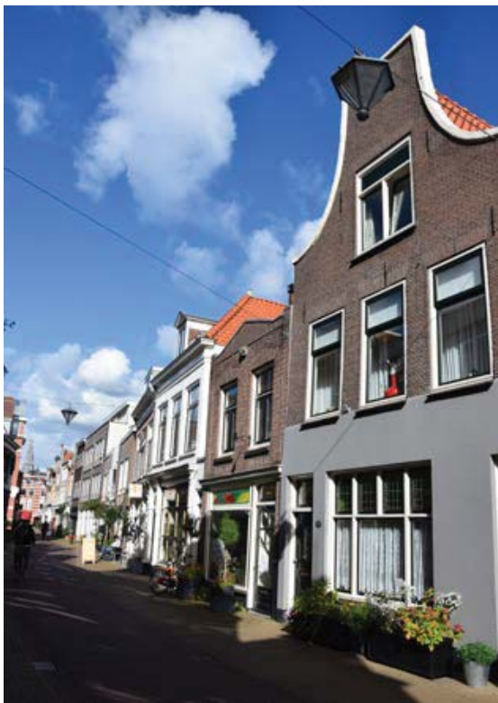
In de huidige situatie sluit de gevellijn niet aan op de belendende bebouwing
