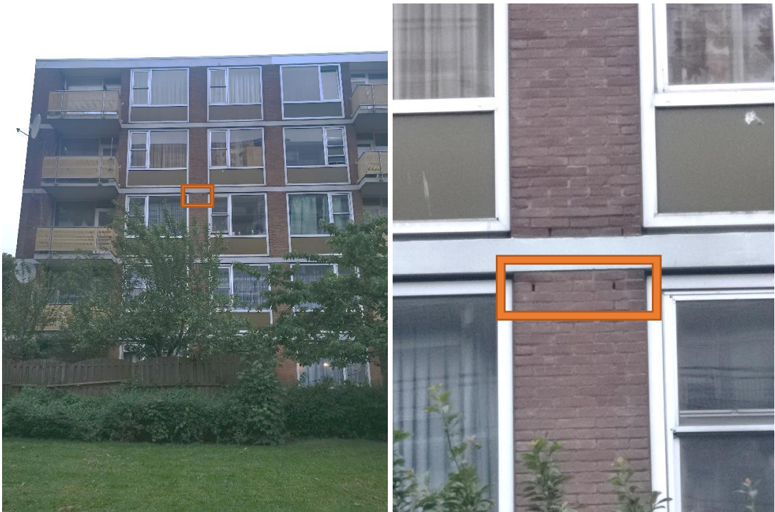
Locatie kraamkolonie zuidkant lange flat
