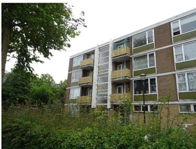
Achterkant flat Louis Pasteurstraat
