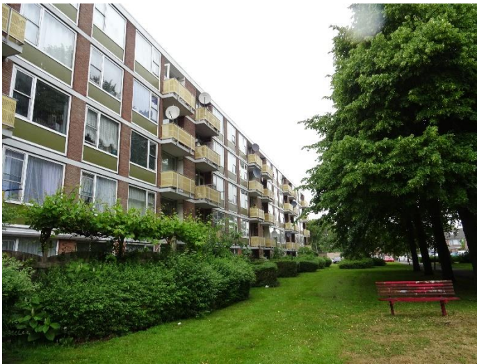
Achterkant flat Louis Pasteurstraat 2
