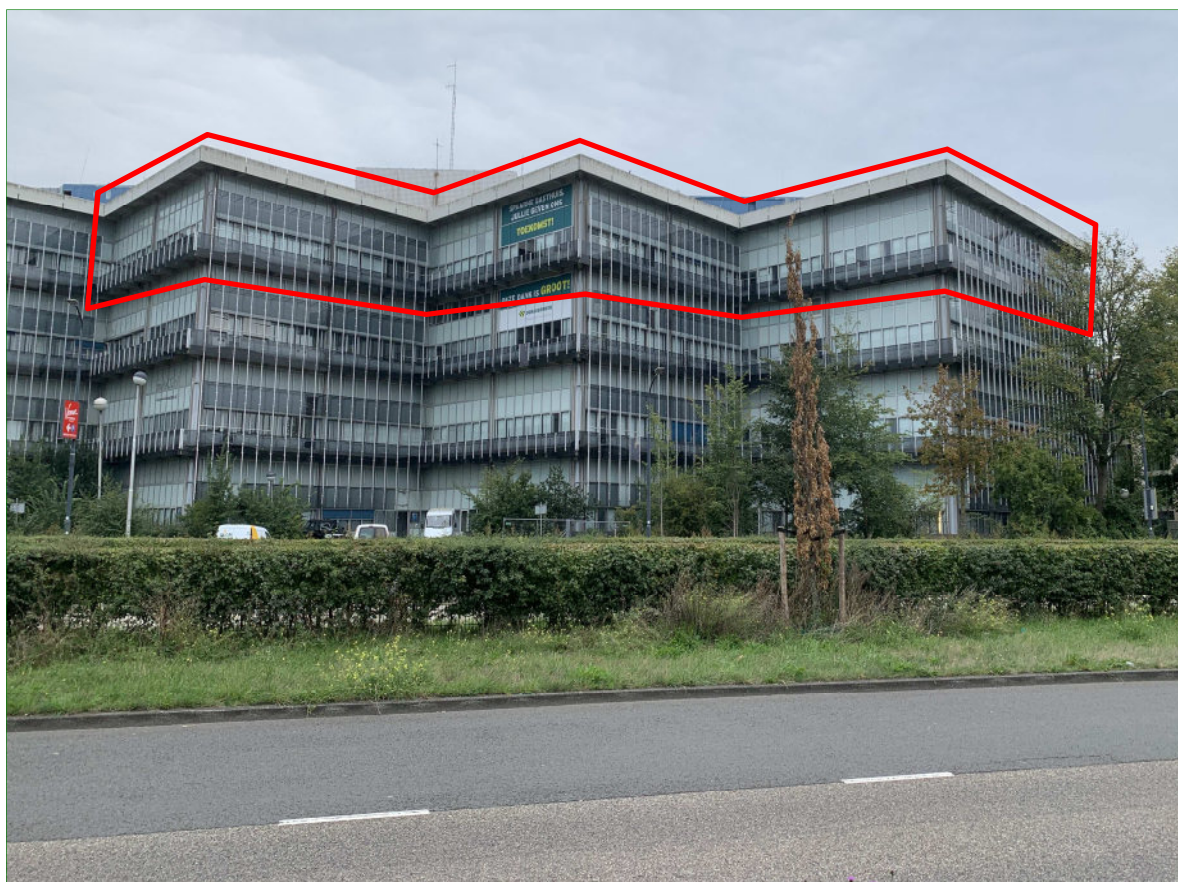
Het deel (rood omgrenst) aan de westkant van de bebouwing waar één verblijvende Gewone dwergvleermuis is aangetroffen.
