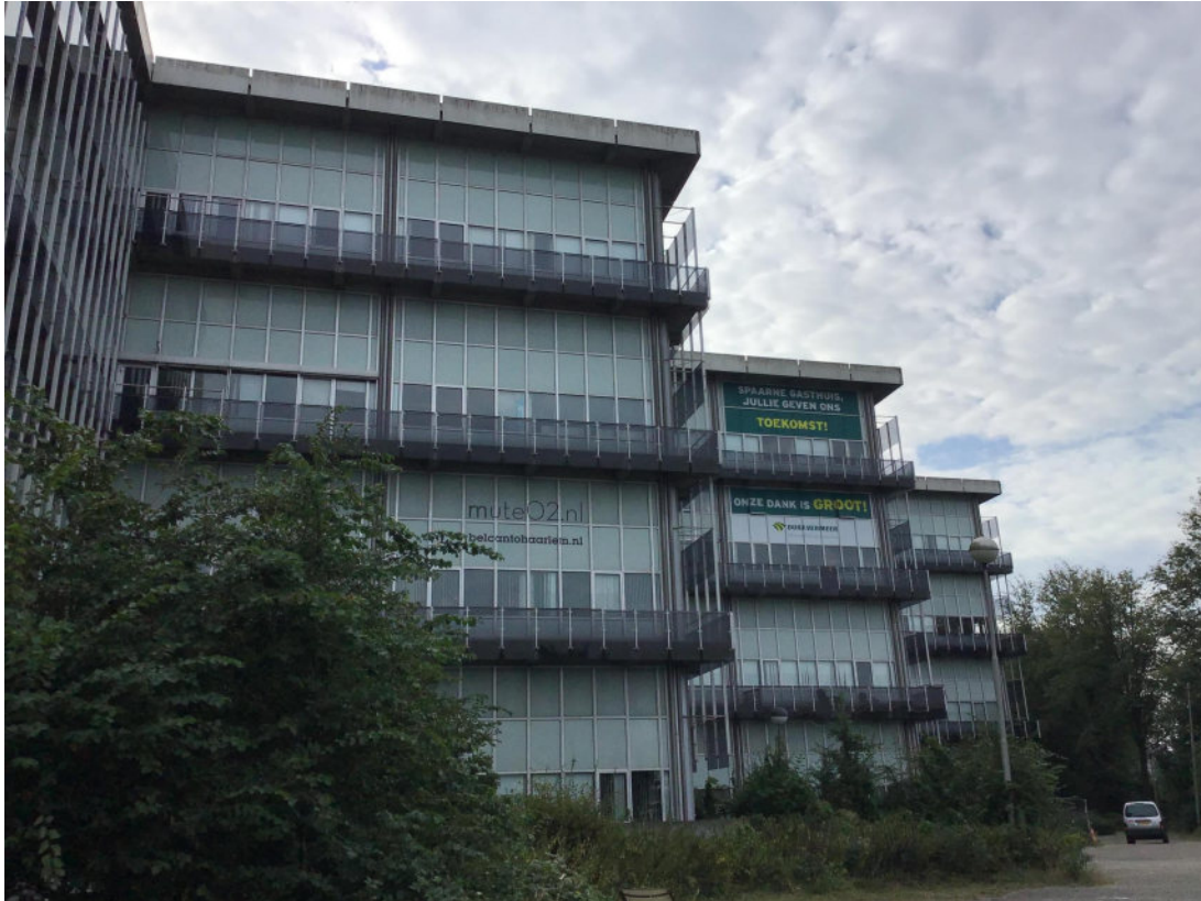
Afbeelding 16: Gevel aan de westzijde.
