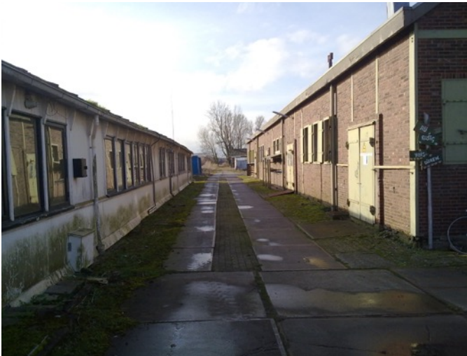
Lange gevel van de werk- en opslagloods
