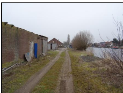
Figuur 6. Overzicht onderzoekslocatie, met te slopen fabriekspand.
