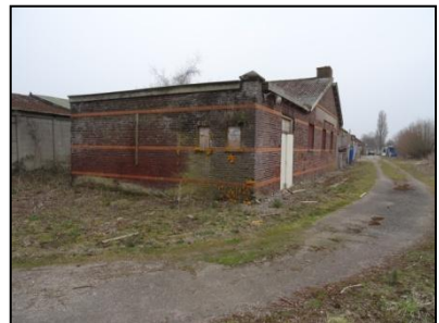
Figuur 5. Voormalige te slopen fabriekshal.
