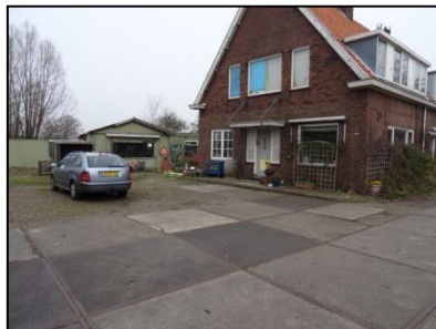
Figuur 4. Te slopen voormalig kantoor.
