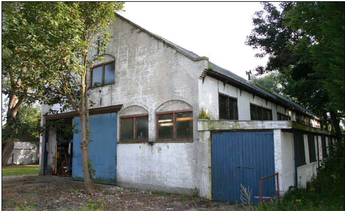
De fabriek gezien vanuit het noordwesten
