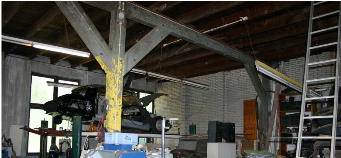
De onderslagconstructie uit 1921
