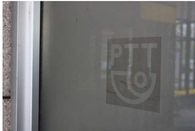
Westgevel en details voormalige publieksentree van het postkantoor.
