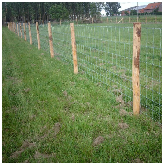
erfafscheiding type 1 - 'paal en draad' hoogte: tussen 1,2 en 1,6 m
