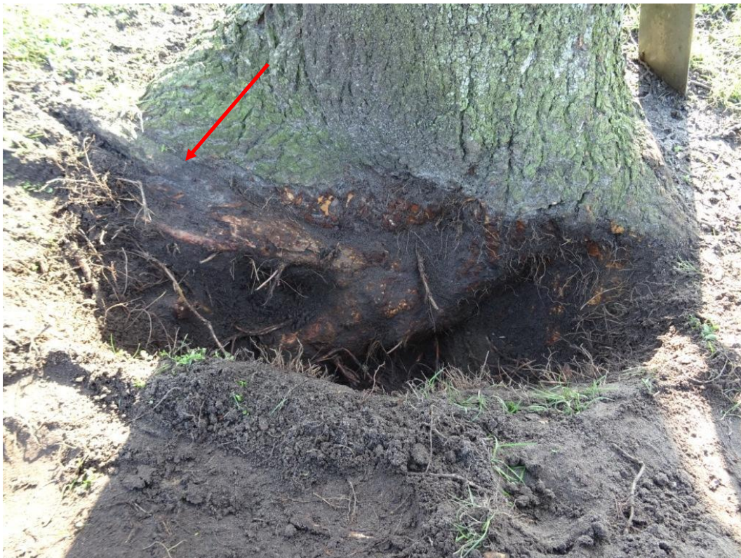
Beworteling van boom 33. Bij de pijl een wurgwortel.
