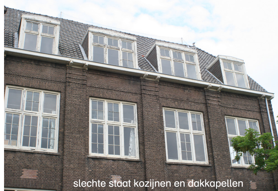
slechte staat gevel binnenterrein
