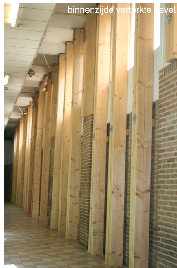
binnenzijde versterkte gevel
