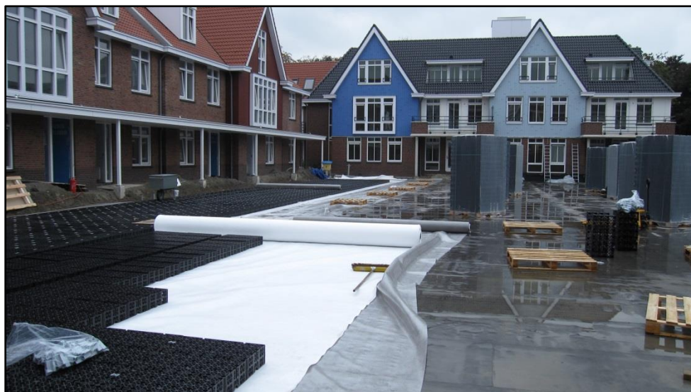
Aanleg Dakwater – waterberging op parkeergarage in Oostvoorne
