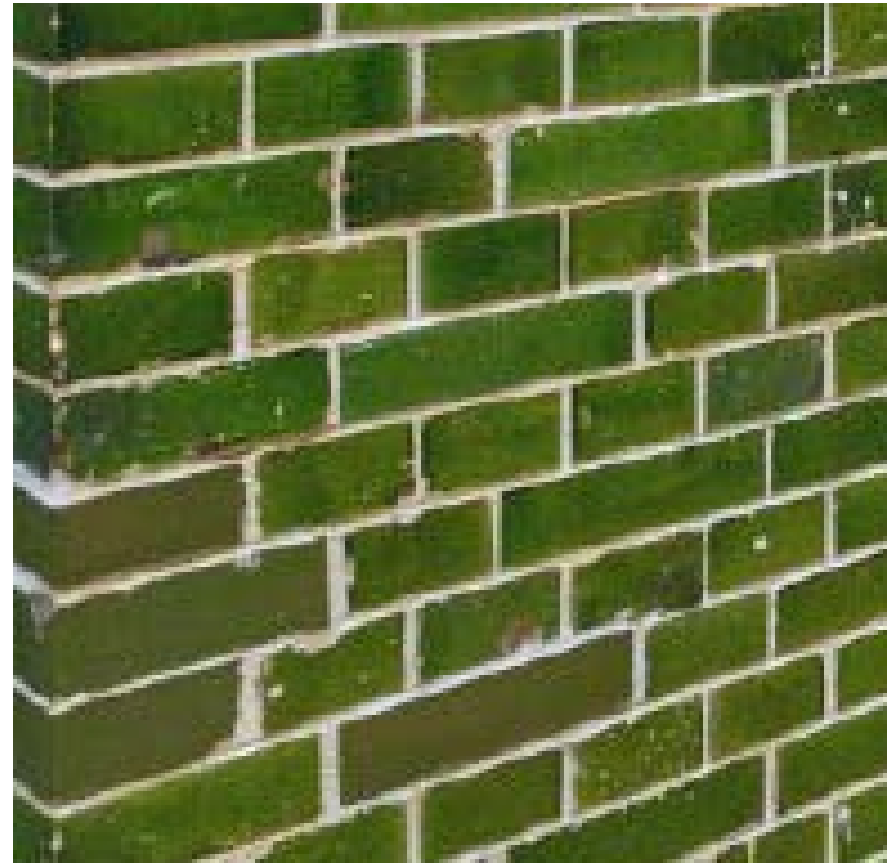
Groen metselwerk waterkant
