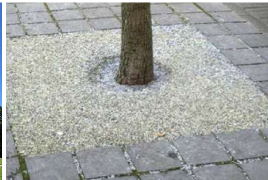
Boomspiegel stalen strip met halfverharding
