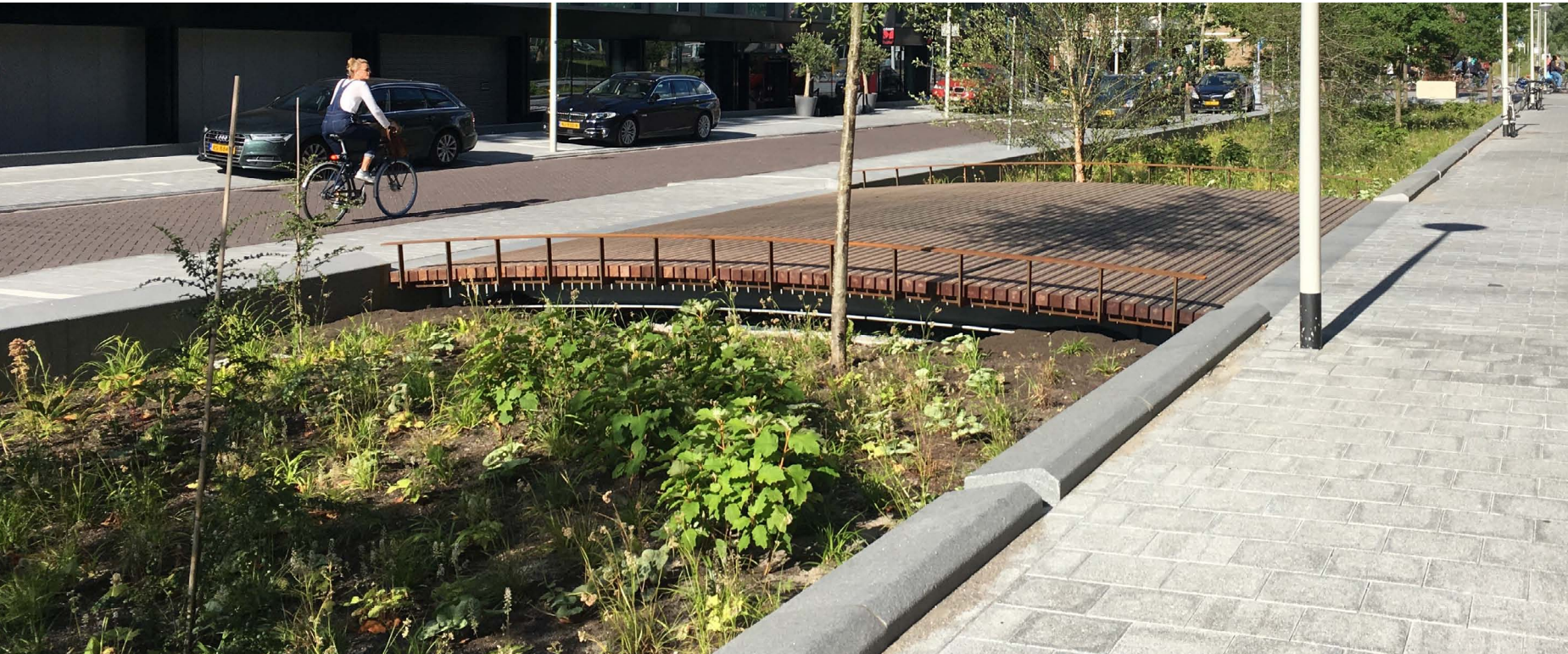
Wadi beplant met vaste planten en bomen en een betonrand als afscheiding
