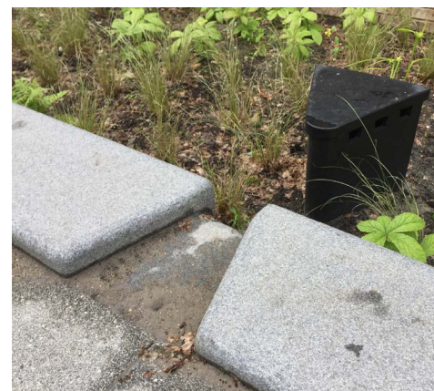
Betonnen rand wadi
