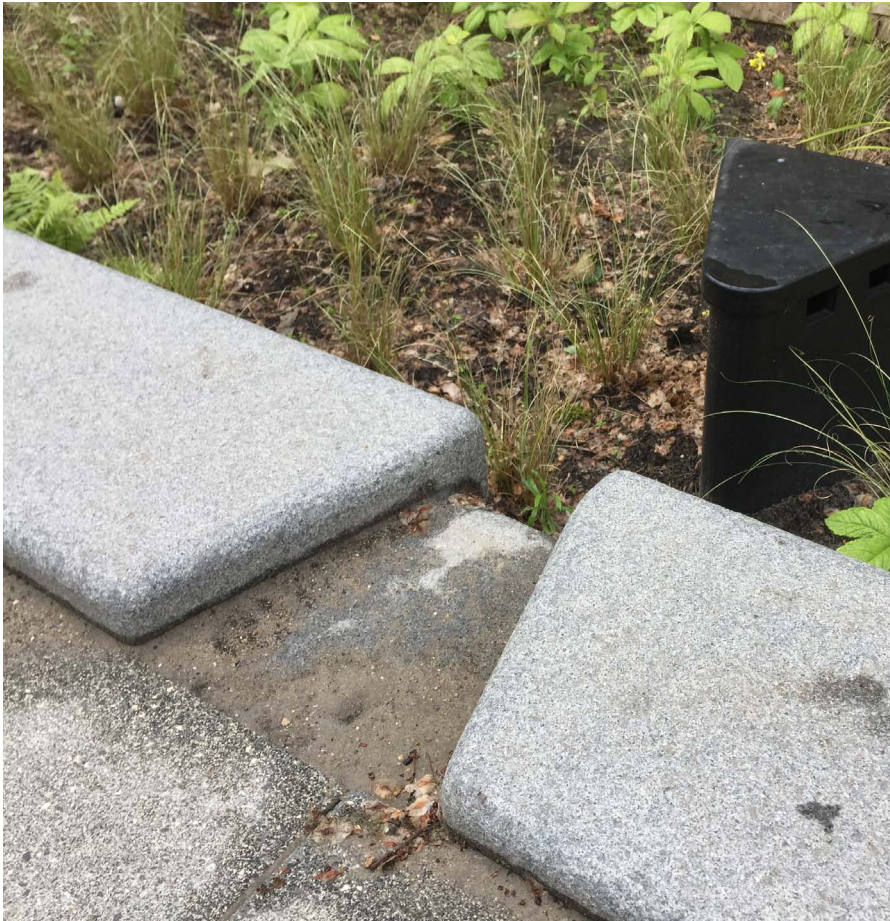
Betonranden wadi: 300mmx400mmx2000mm Met inkepingen voor waterafvoer richting de wadi
