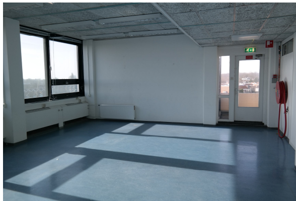
Links een originele lichtbak, rechts de opbouw tl bakken , de opbouw kabelgoot en convectoren.
