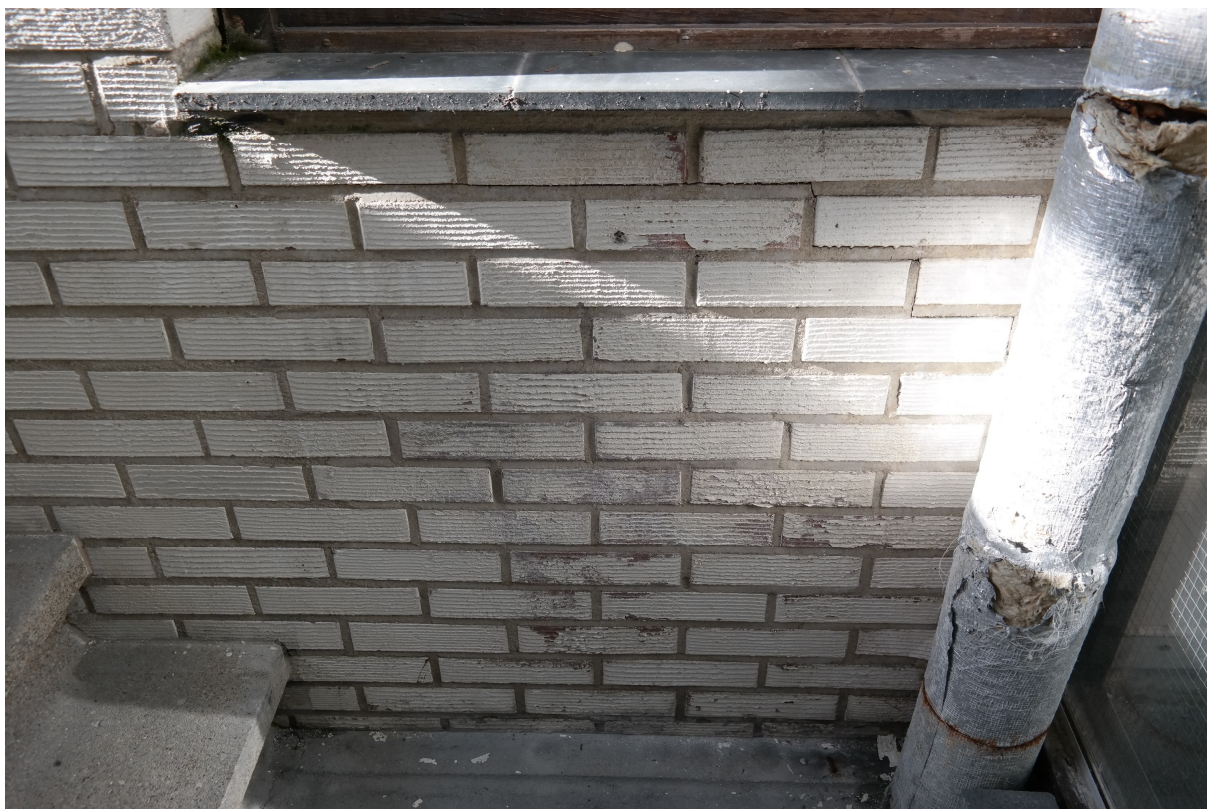
In het achterste trappenhuis zijn de originele witte bakstenen nog niet geschilderd. Ook hier begint de toplaag echter los te komen. Mogelijk was dat de reden om de muren in het voorste trappenhuis geheel wit te schilderen.
