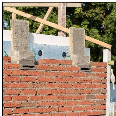
Afbeelding 3: Inbouwstenen die worden geplaatst
