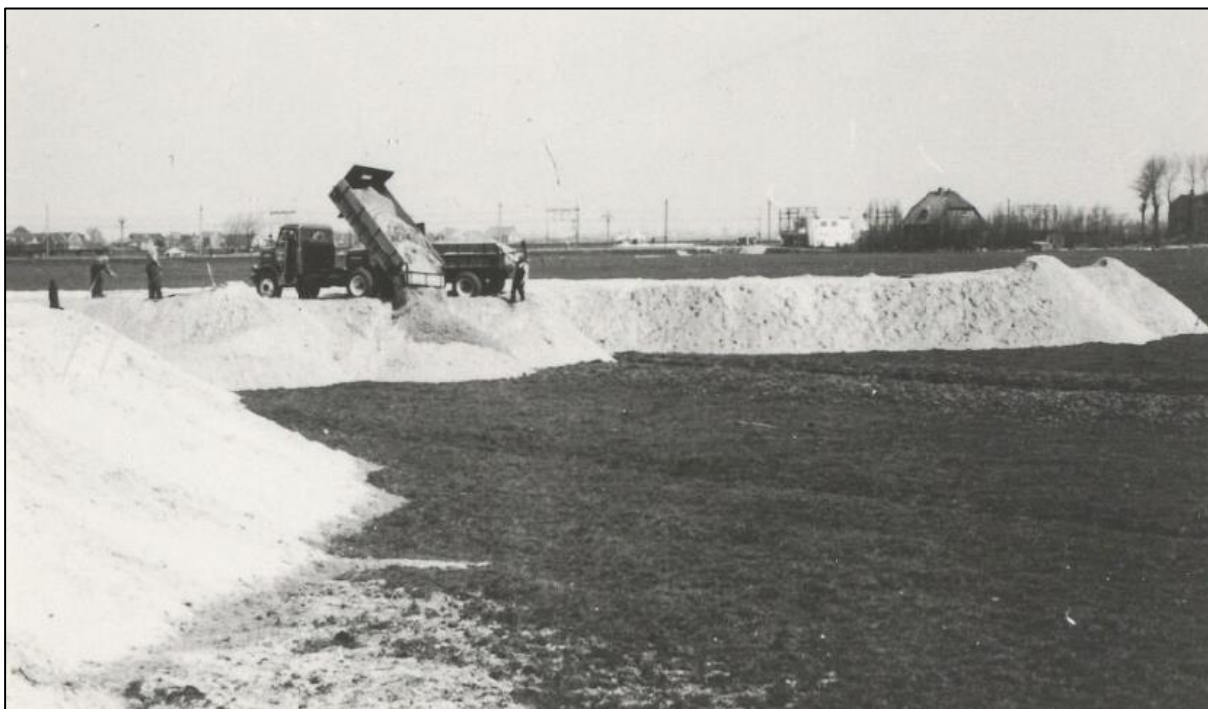
Figuur 11: Opbrengen van duinzand voor het bouwrijp maken van de Parkwijk, 1956 (Beeldbank Noord-Hollands archief, inventarisnr. NL-HlmNHA_1100_24237).
