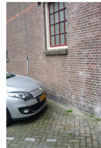
Figuur 45: Mogelijke ligging van tank 3, langs zuidoostelijke gevel van woning Harmenjansweg 6
