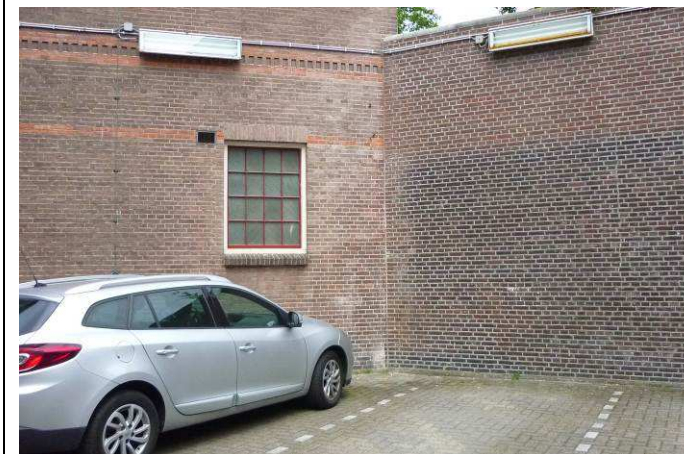
Figuur 42: Huidige remise, naast woning Harmenjansweg 6
