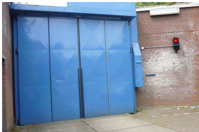
Figuur 40: Huidige remise, naast woning Harmenjansweg 6
