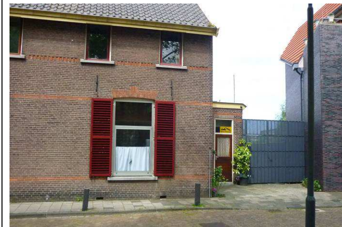
Figuur 51: Voorgevel woning Oostvest 16 met rechts toegangshek tot groenstrook aan noordgrens van onderzoekslocatie
