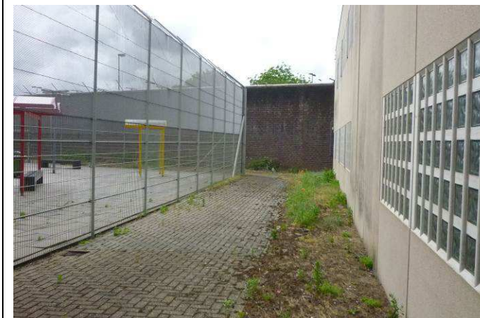
Figuur 39: Luchtplaats aan zuidzijde van Koepel
