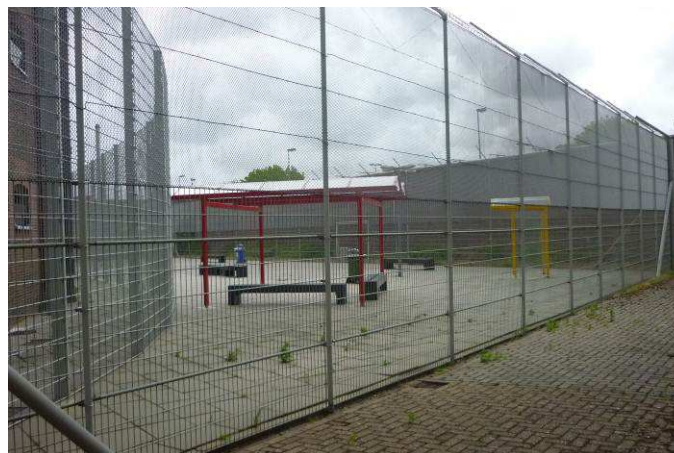
Figuur 38: Luchtplaats aan zuidzijde van Koepel
