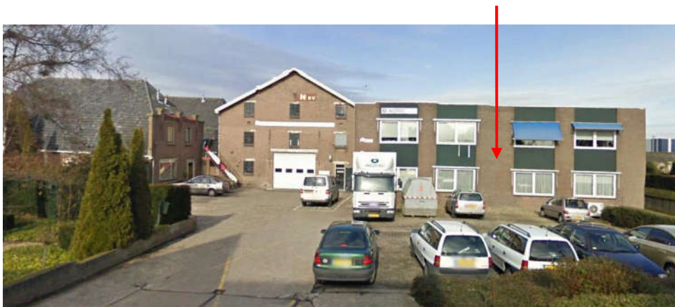
afb. 4 Het te slopen kantoor- en bedrijfsgebouw rechts van de bollenschuur
