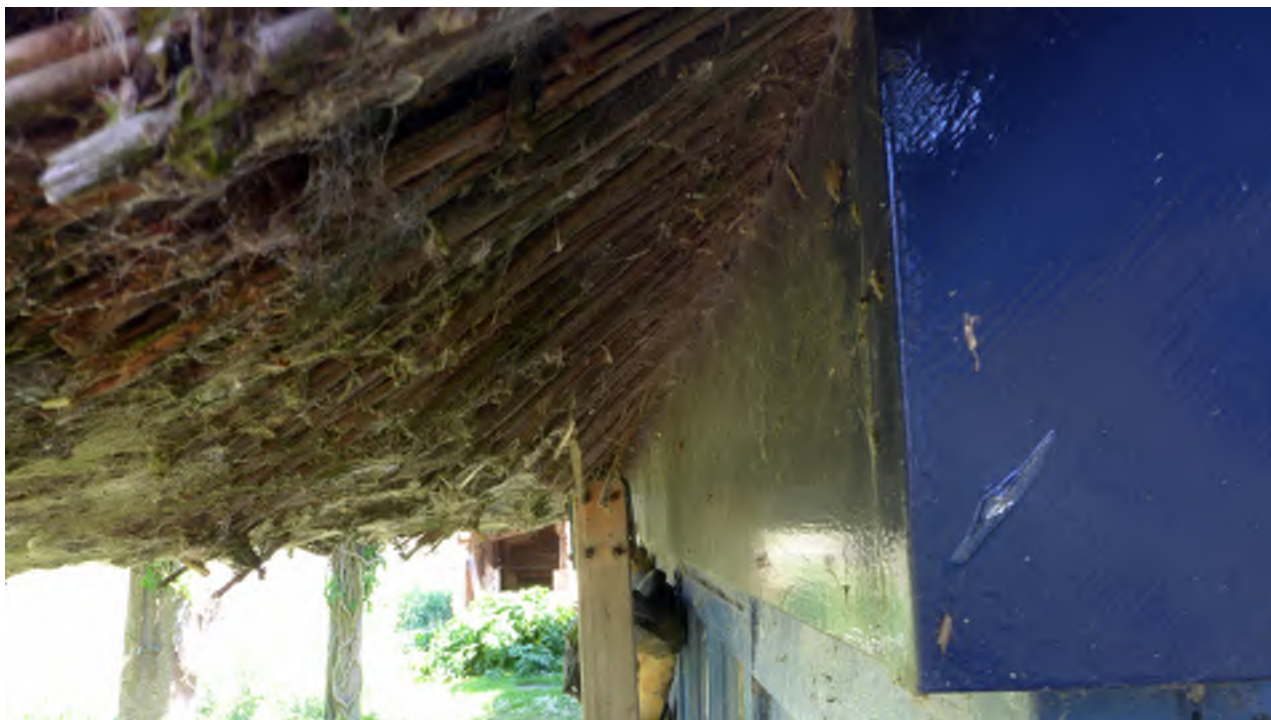
Afb.5: Overgang van muur naar dak is strak en zonder kieren. Daarnaast spinnenrag indicatie voor de afwezigheid van in en uitvliegende vleermuizen.
