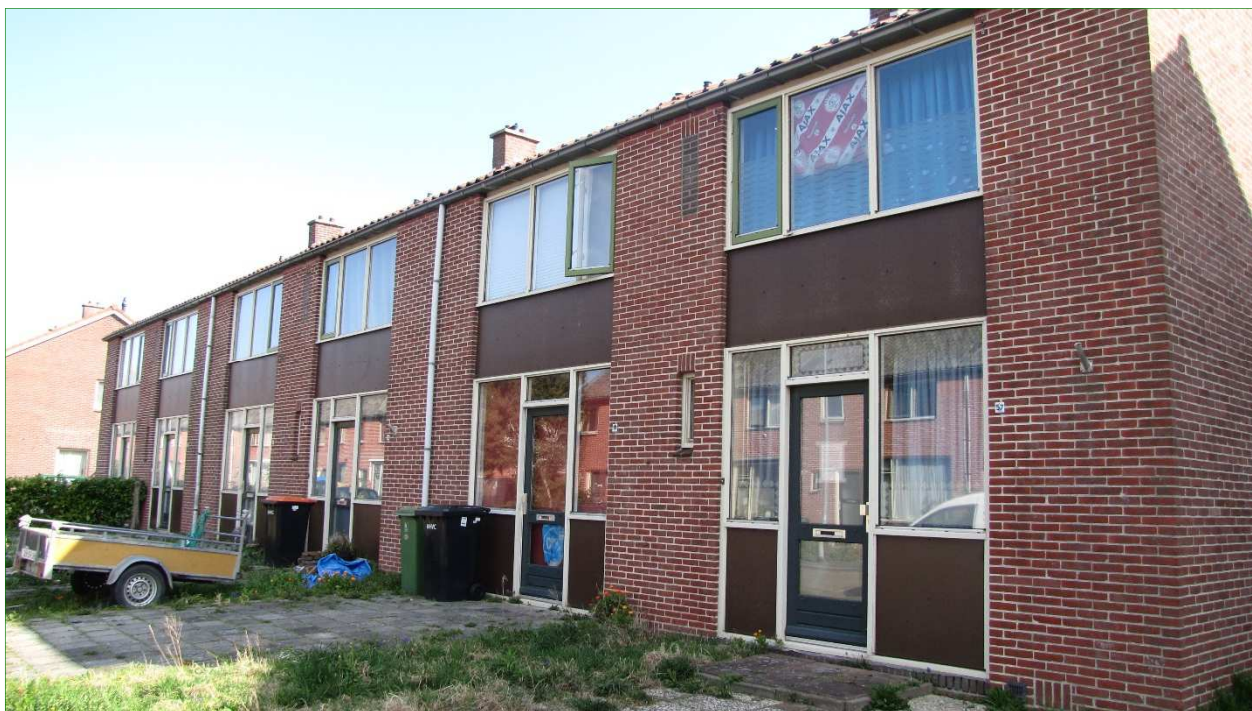
Het zuidelijk gelegen blok eengezinswoningen in het plangebied.
