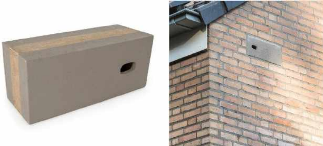
Figuur 5. De gekozen inbouwstenen voor nieuwe permanente verblijfplaatsen van gierzwaluwen en huismussen (links) en een impressie van de wijze van inbouwen (rechts). (bron: Vivara Pro)
