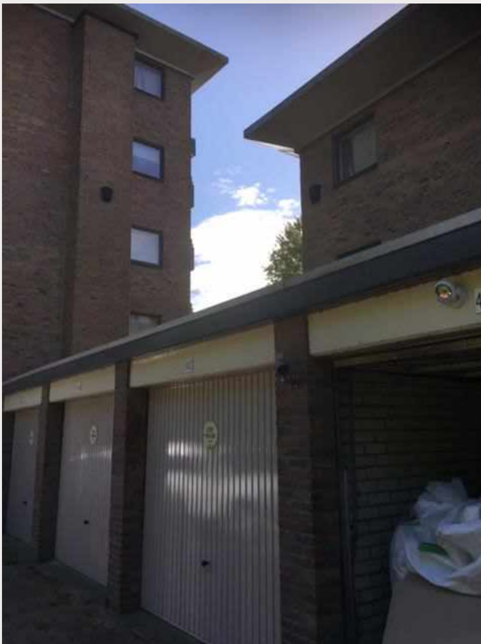
Afbeelding 20: Appartementencomplex Asterstraat Noordgevel van zuidelijke vleugel (links op de foto) en oostgevel van noordelijke vleugel (rechts op de foto).
