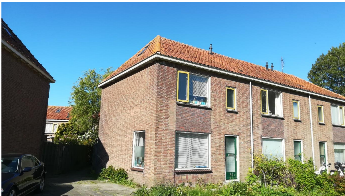
Figuur 7. Het woningblok Asterstraat 20-22. In het schuine linkerdakvlak van deze woning broeden gierzwaluwen, die ter hoogte van het zolderraam invliegen tussen de kieren van scheefliggende dakpannen.
