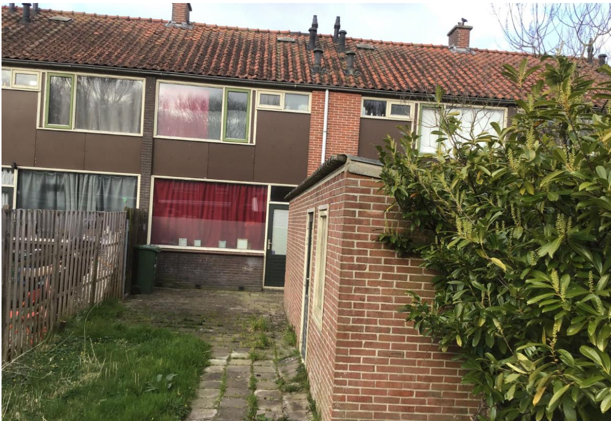
Figuur 4: situatie ter plaatse van een schuur met asbestverdacht dak (achtertuint).
