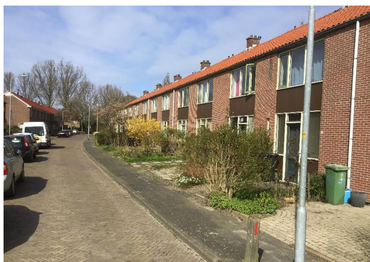
Figuur 1: Situatie ter plaatse van de bebouwing en de voortuinen.
