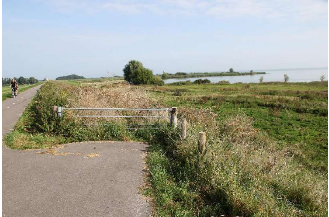
Noordelijk deel dijkvoet
