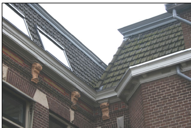
Ruimte tussen dakpannen van de oudere bebouwing binnen het plangebied.
