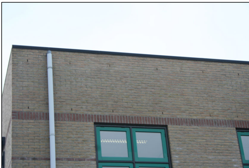
Ventilatiegaten naar de spouwmuur van het kantoorgebouw Apollo.
