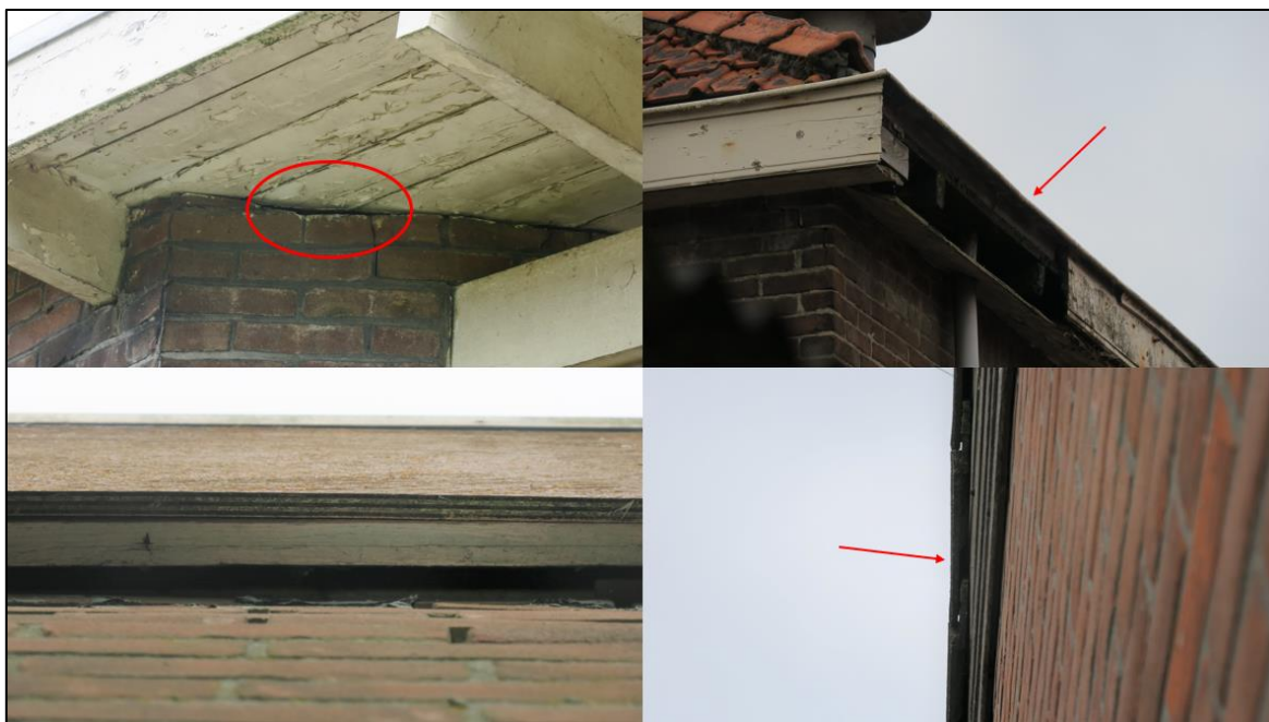
Figuur 3.2 Weergave van invliegopeningen in de bedrijfsbebouwing op de planlocatie.
