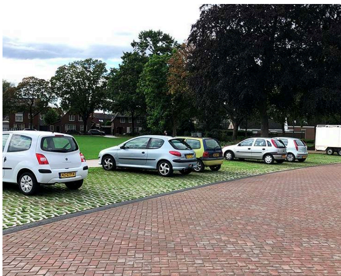
Het voorterrein inrichten met gebakken klinkers voor de rijbaan en grasbetonstenen voor de parkeerplaatsen
