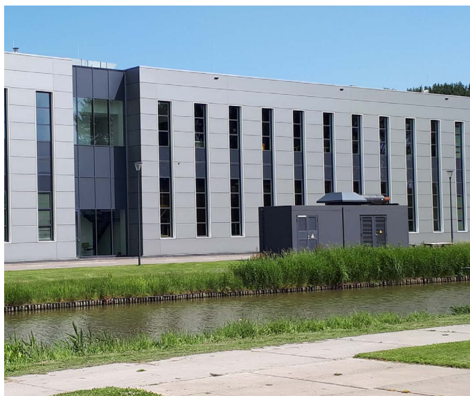
Ongecompliceerde overgang naar het landelijk gebied; trafo in een gedekte kleur
