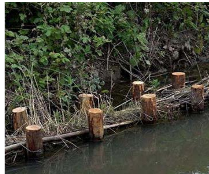
Aanbrengen natuurvriendelijke beschoeiing (onder water) aan de oostzijde van de Zandsloot
