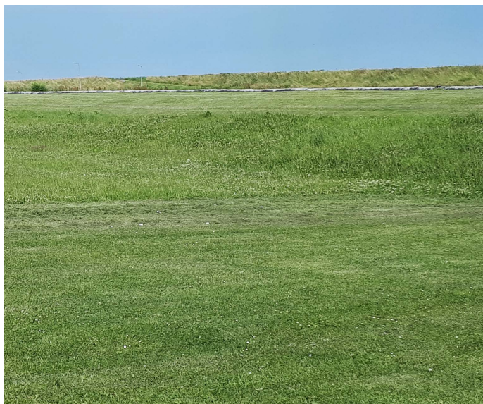
Waterbassin ingepast met flauwhellend grastalud (hoek Oosterdijk en Elsenburg)
