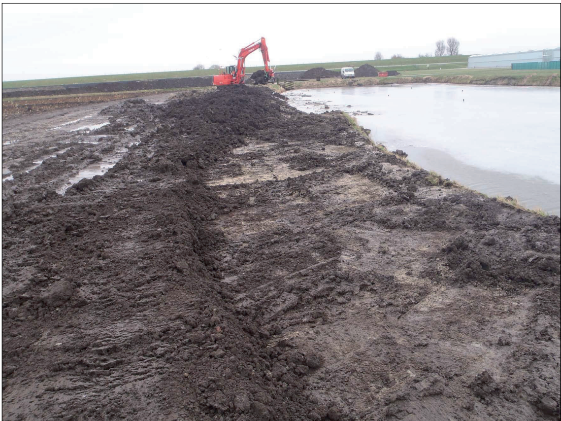
Afb. 7 Impressie van het graven van de waterpartij in deelgebied 1.
