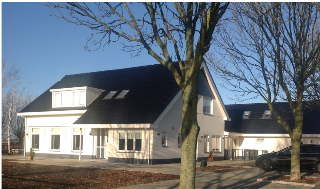
Situatie na renovatie bedrijfswoning en aangebouwde paardenstal
