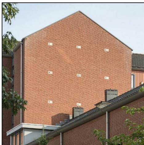
Afb 8 + 9: Gierzwaluwkasten ingemetseld (worden ook gebruikt door Huismussen)
