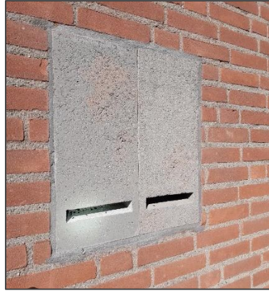
Afb 11: Inbouw vleermuiskast
