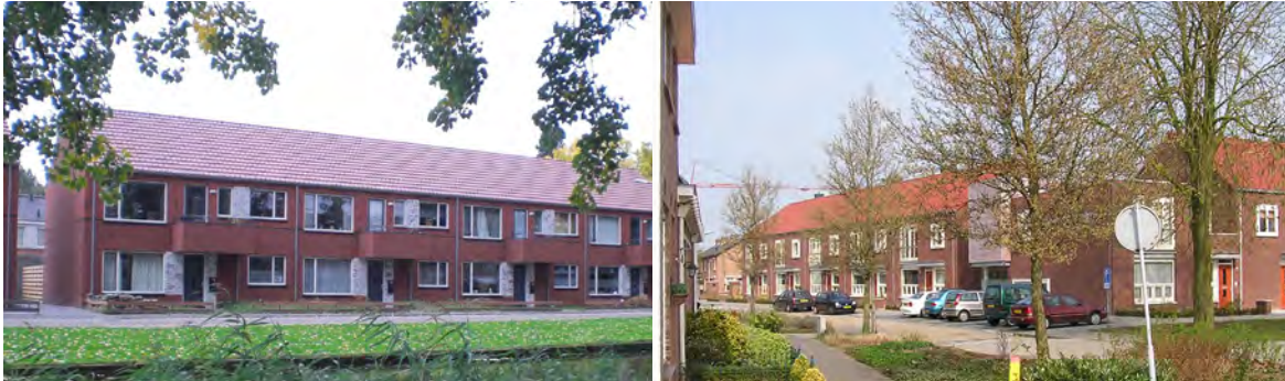
De nieuwbouw van de boven-benedenwoningen sluit aan op het architectuurbeeld van de traditionele laagbouwbuurt. Belangrijk daarbij zijn alle voordeuren aan de straat.
