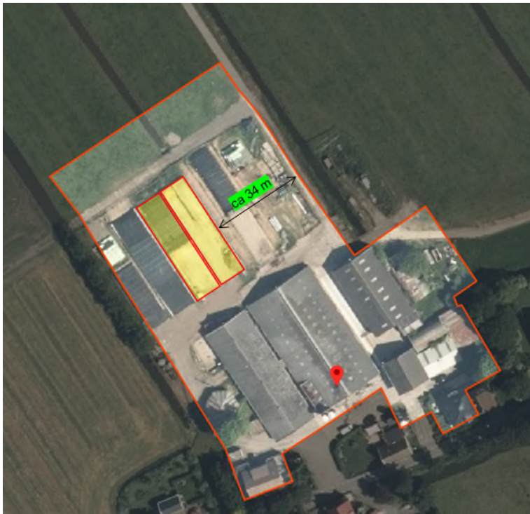
Figuur 3: onderkelderde sleufsilos
