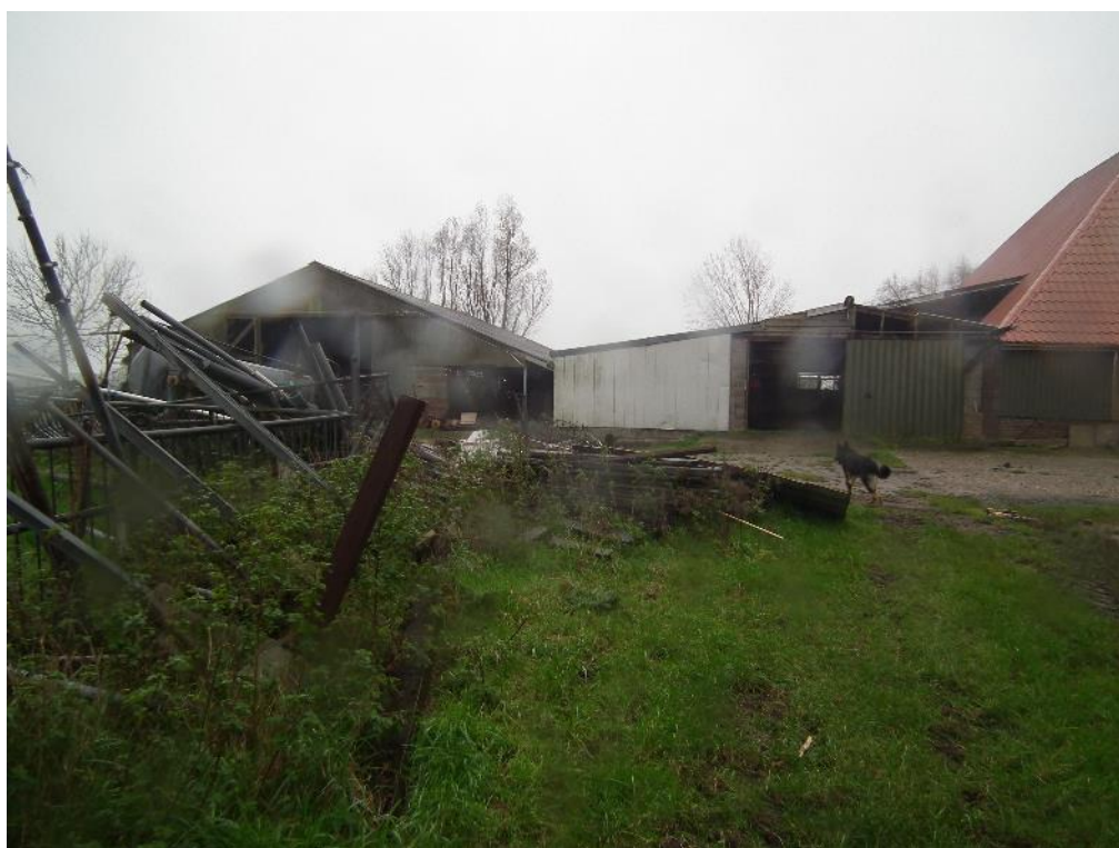
Figuur 2 De oostelijk gelegen opstallen wordt gesaneerd ten behoeve van 2 woningen
