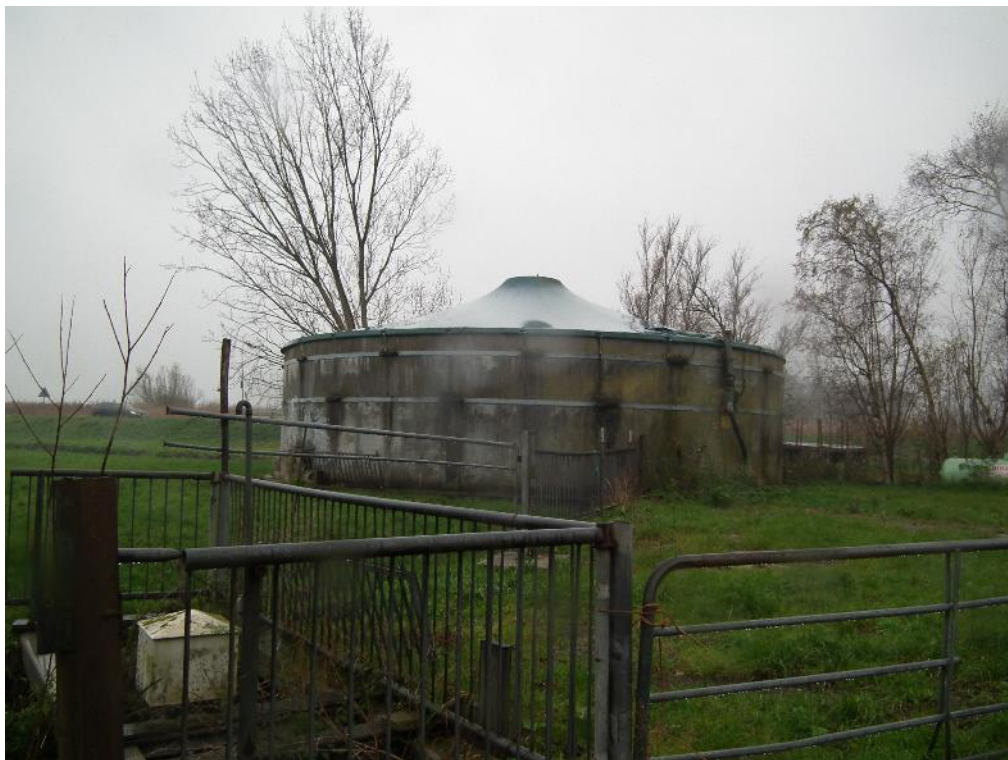
Figuur 3 De te saneren mestilo, bestaand uit betonelementen en een spandak
