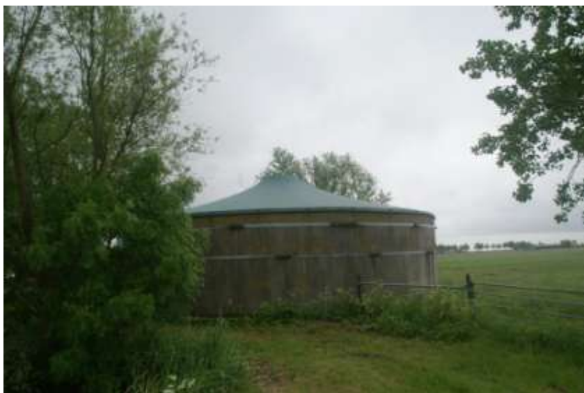
zicht op de bouwlocatie van de tweede woning
