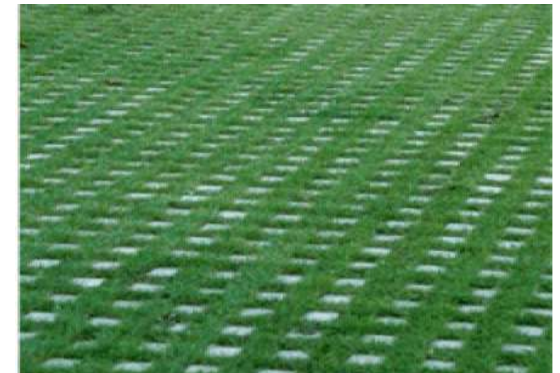
halfverharding met grasbetonstenen
