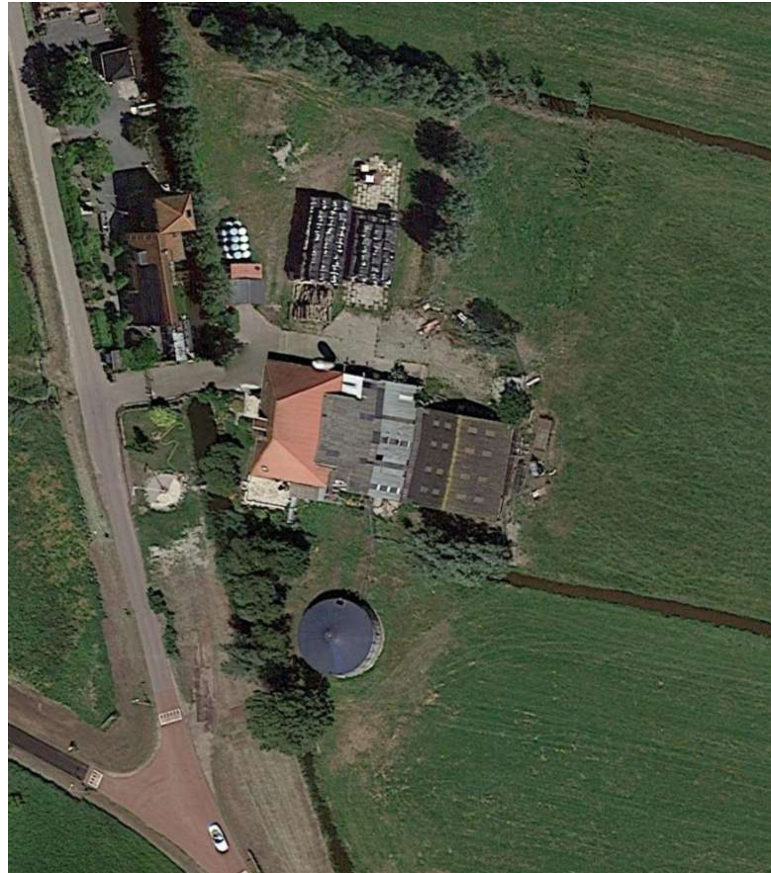
bestaande situatie Buitengouwweg 2
